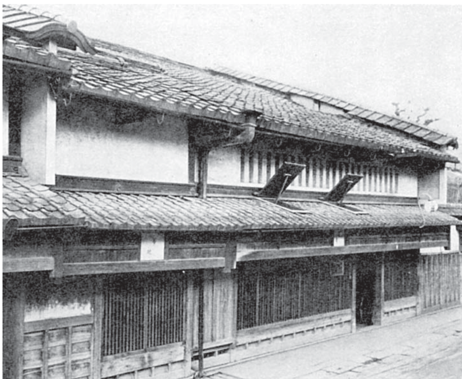
Typisk Nishijin-machiya med lyslemme i taget, som kunne åbnes for at få bedre lys til arbejdet med de tynde silketråde
