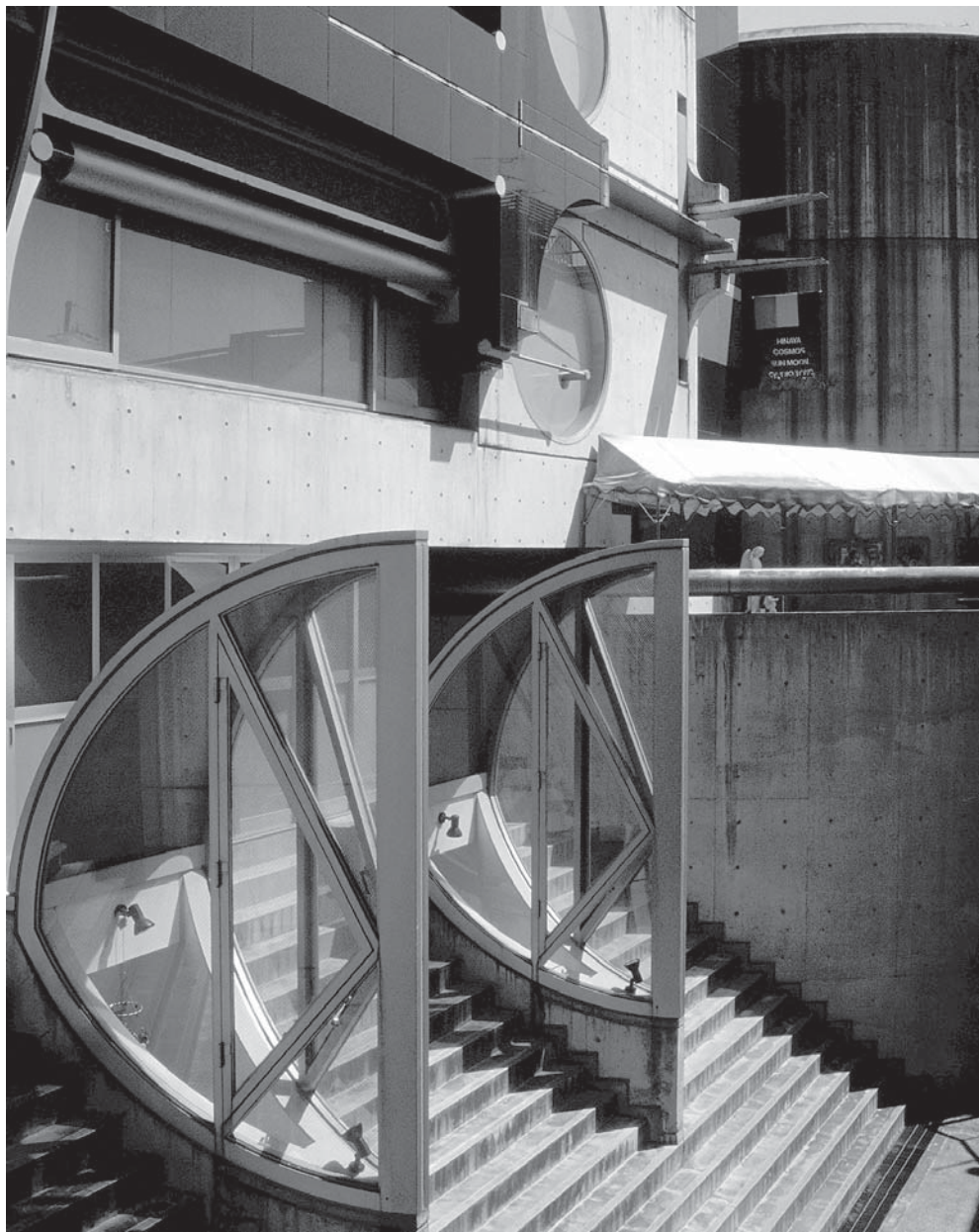
Origin III, vinduesåbninger i sydfacade. Origin II's rundede betongavl ses bagest
